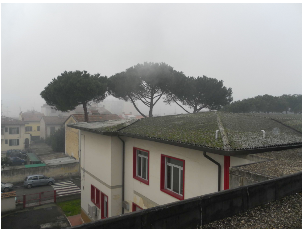
Foto 2 : Copertura della scuola
