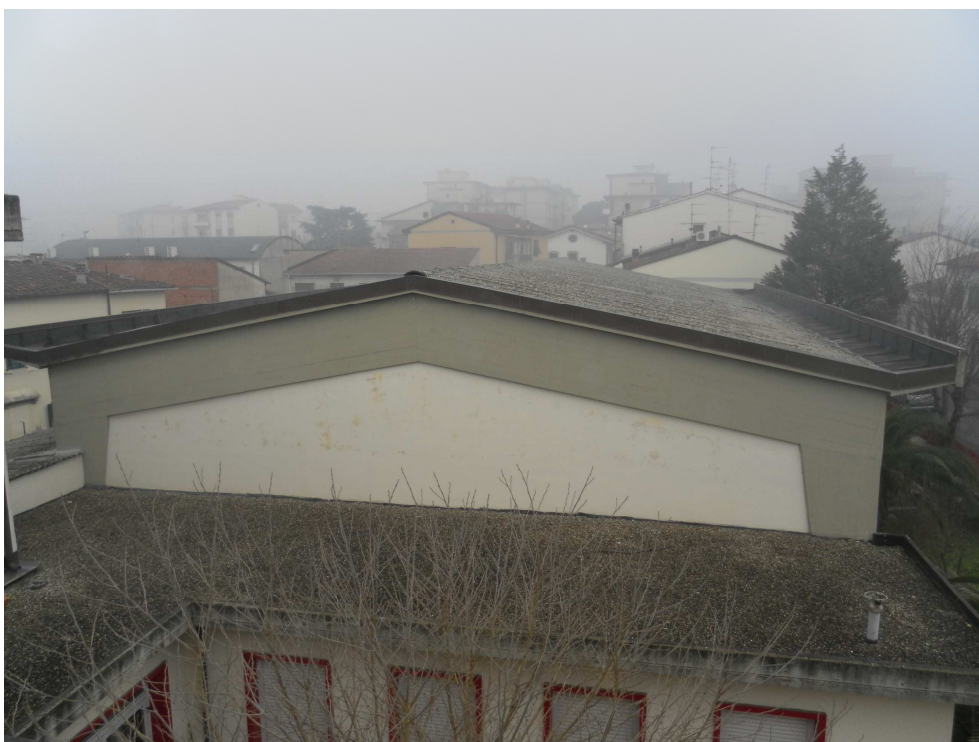
Foto 4 : Palestra ed ingresso alla stessa
