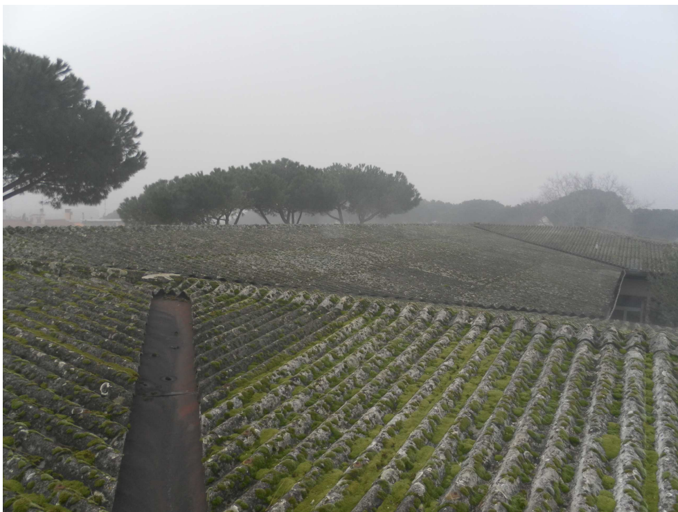
Foto 3 : Particolare copertura in amianto
